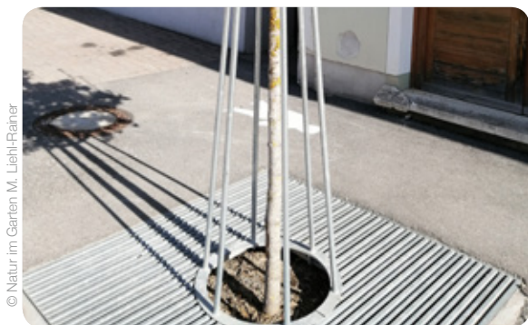
Geschützte Baumscheiben bestehen aus Metallrosten die belastungsstabil sind und Versickerung zulassen.
