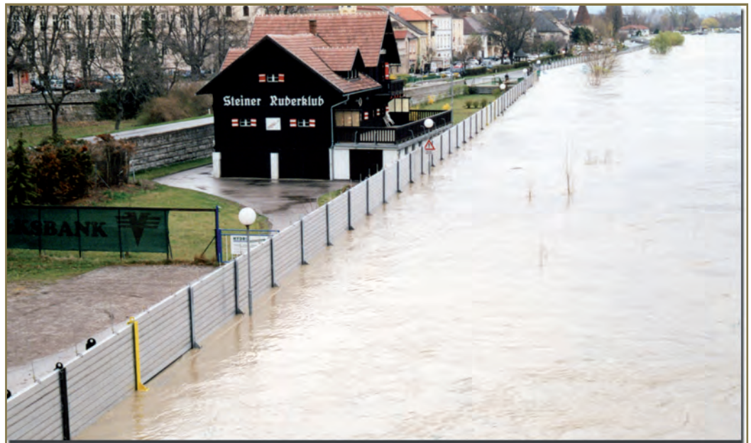
Der mobile Hochwasserschutz in Krems und Stein wird von der örtlichen Feuerwehr bei drohendem Hochwasser aufgebaut und er hat schon mehrmals große Schäden verhindert. Ein typisches Beispiel öffentlicher Vorsorge von Donaugemeinden.
