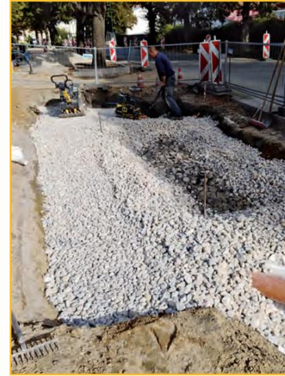
4 Verteilschicht für Wasser und Luft einbringen
