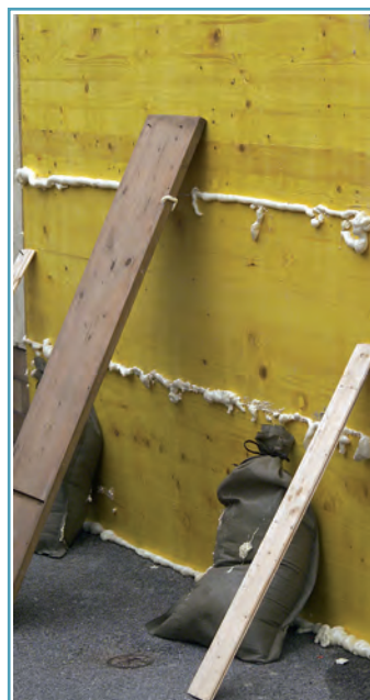
Behelfsmäßiger Gebäudeschutz mit PU-Schaum (Montageschaum) und Doka-Platten
