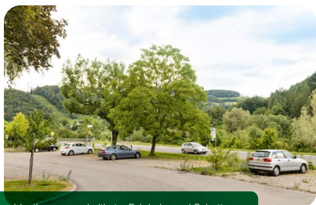
Kombination aus asphaltierter Fahrbahn und Schotterrasen-Parkflächen
