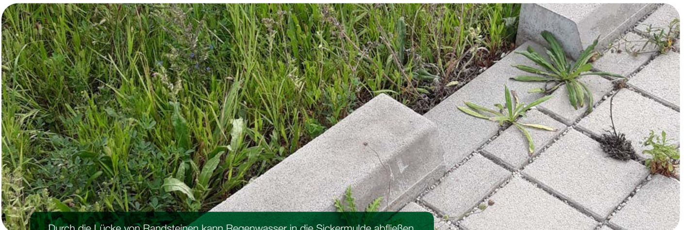
Durch die Lücke von Randsteinen kann Regenwasser in die Sickermulde abfließen.
