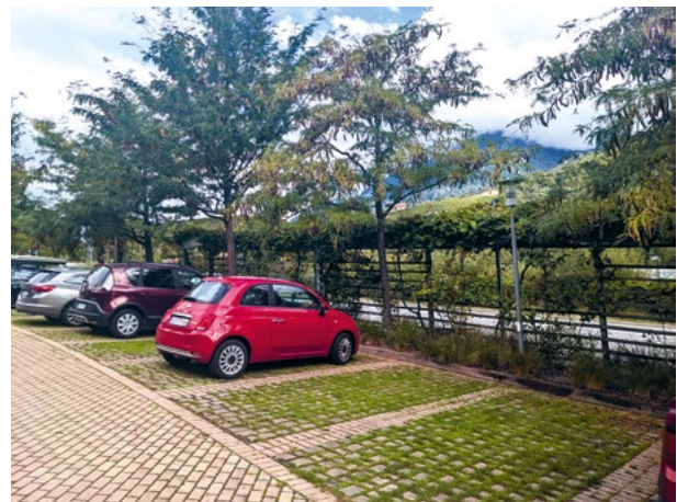
Verschiedene Ausführungen von Parkplätzen mit sickerfähigen Belägen und Baumpflanzungen. | © „Natur im Garten“
