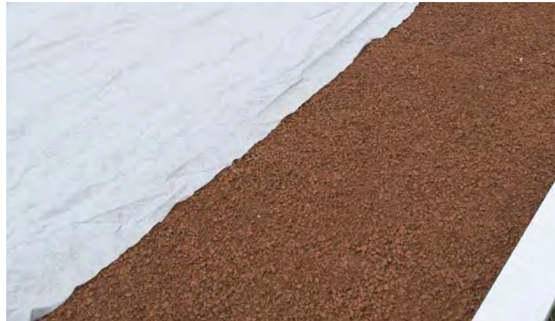
Drainageschicht: Ziegelsplitt und Filtervliesabdeckung an der HBLFA Raumberg-Gumpenstein Foto: W. Graiss
