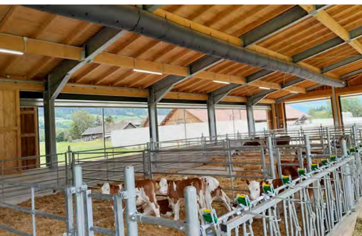
Ausreichend große Zuluftflächen sorgen für ein gutes Klima Foto: I. Mösenbacher-Molterer
