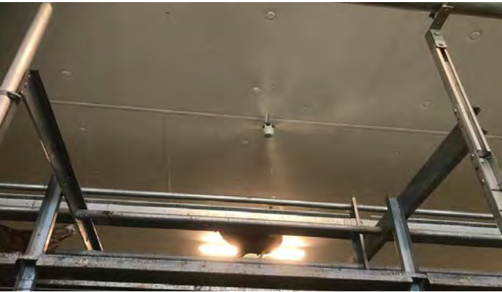
Feinste Vernebelung von Wasser kühlt die Stallluft Foto: I. Mösenbacher-Molterer
