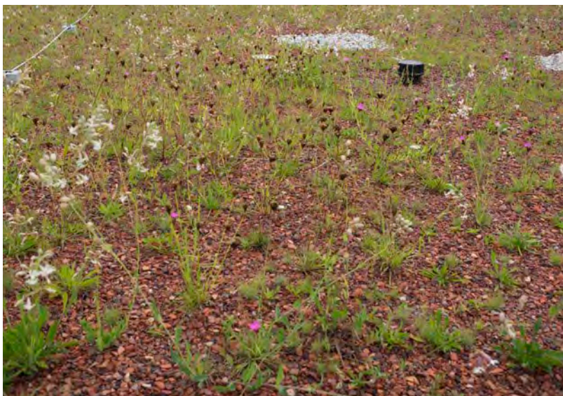
Extensive Dachbegrünung auf Substrat Claylith mit 5 Masseprozent organischem Anteil Foto: W. Graiss
