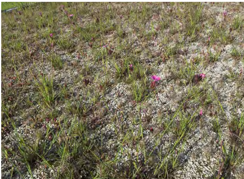
Extensive Dachbegrünung mit Dachsteinkalk mit 10 Masseprozent organischem Anteil Foto: W. Graiss
