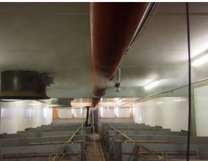
Kühlung der Stallluft durch Zweistoffdüsentchnik
